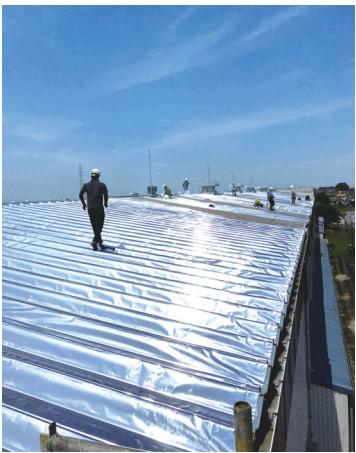
太田SCの屋根全面に設置した遮熱シート
