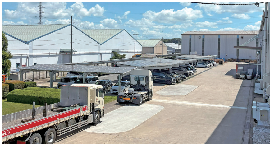
事務所棟のほか、カーポートの屋根にも設置
